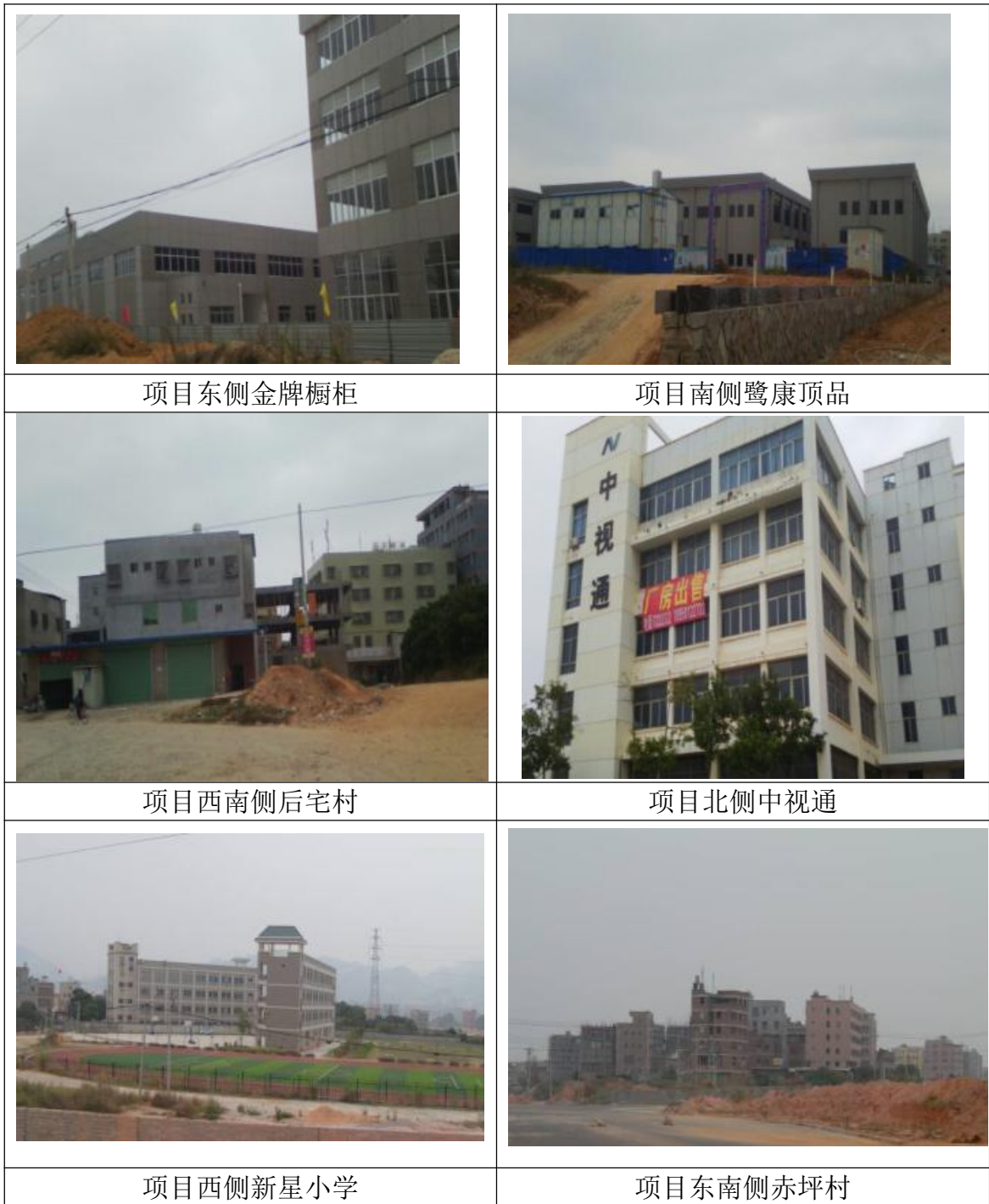
附图 4 项目四周环境现状及项目现状照片
